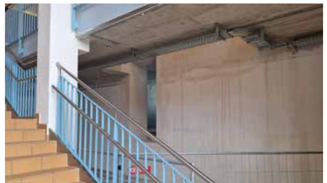
Erweiterung (Durchbruch) der neuen Horträumlichkeiten
